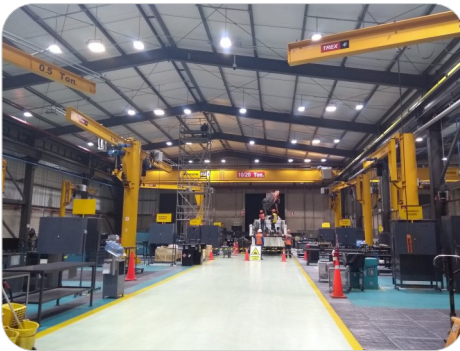
Proyecto: Instalación de luminarias
