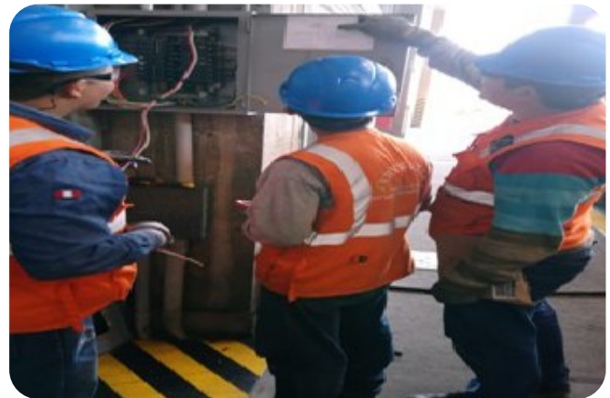
Mantenimiento de Tableros Eléctricos
