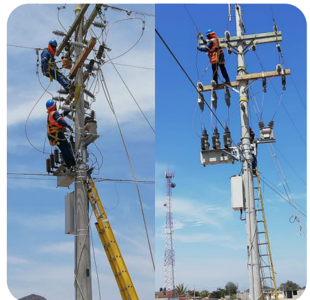
Red de distribución eléctrica Red Primaria
