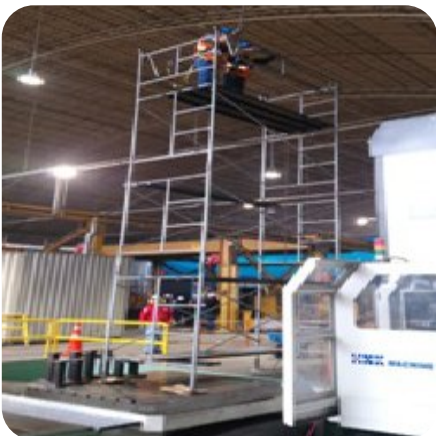
Instalación de Luminarias
